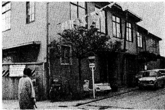
旧土木局南工営所
