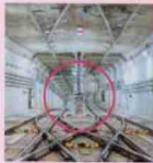
▲天下茶屋駅北トンネルの完成
