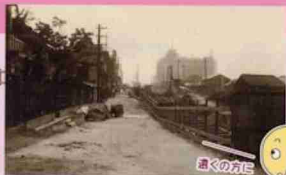
▼御堂筋線の工事の様子▶ (1937年ごろ)
