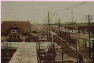
▲高梁海々線工事中の鉄ノ茶屋駅あたり (1937年ごろ)
