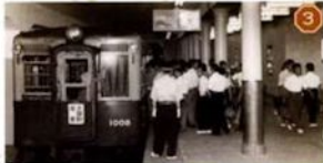
3 戦時中に工事がストップしていた国道26号線下の地下鉄建設が再開され、花御町より再岸里・玉出と延伸された。写真は1944年の岸里駅の写真である。
