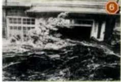
6 1950年9月のジェーン台風は、高潮被害が激しく、西成区では十三間瀬川以西の津守地区が冠水してしまう。その時の津守小学校の災禍の写真である。
