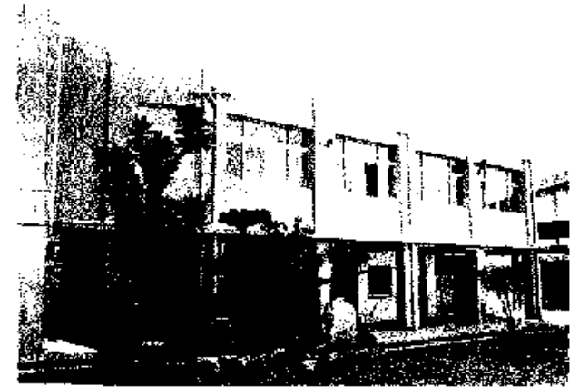
▲南校舎全景(昭和54年10月)
